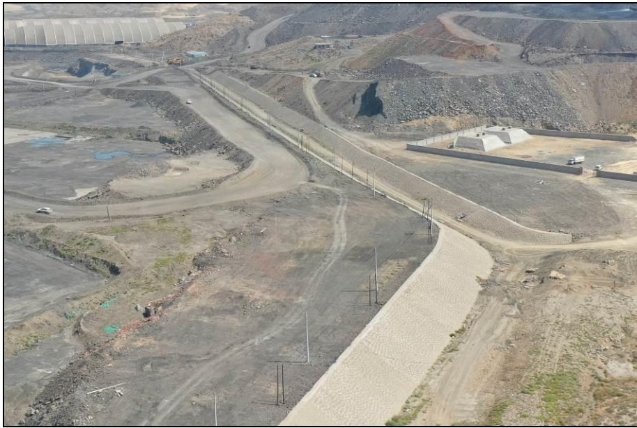
照片 4-11 泄洪渠东段
