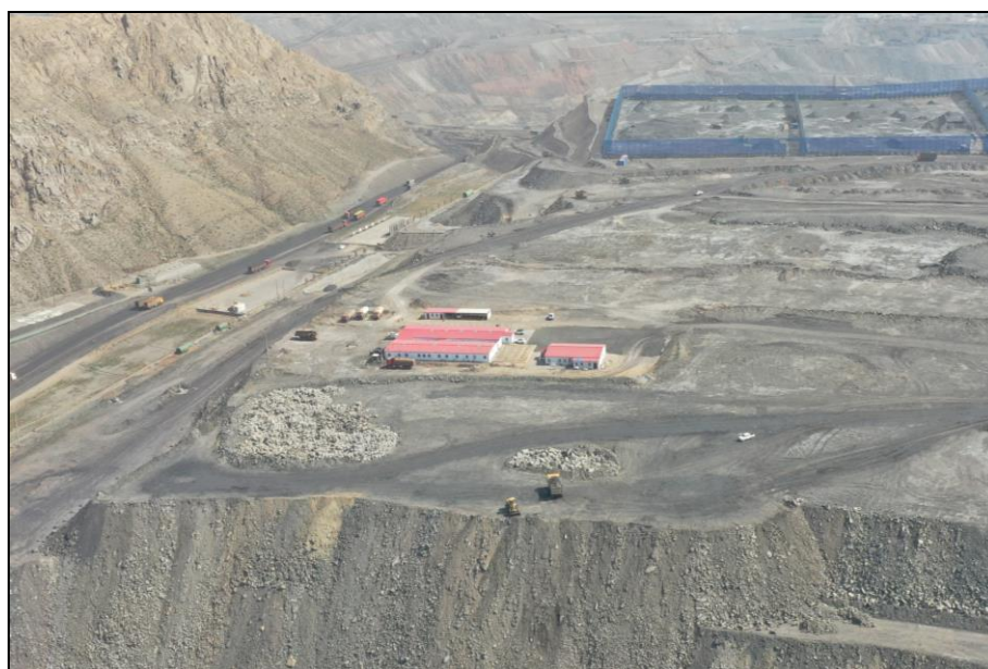
照片 4-6 华银二矿办公区
