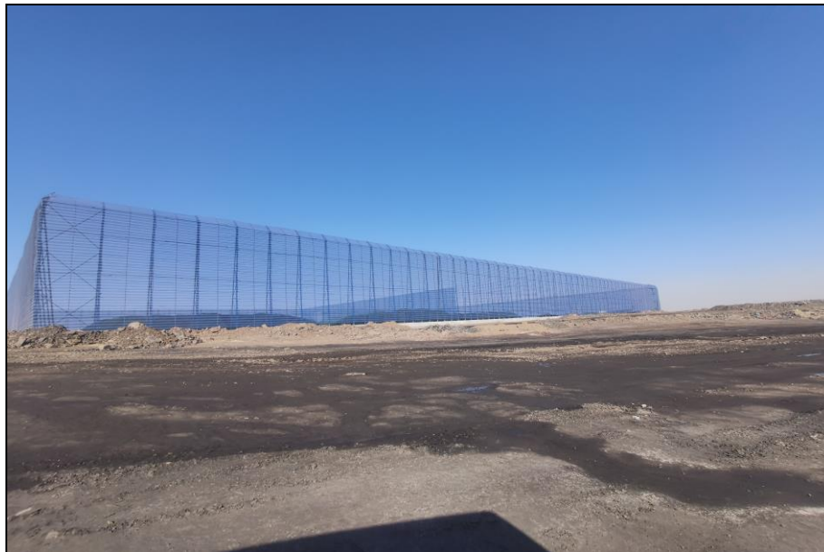
照片 4-3 华银三矿储煤场
