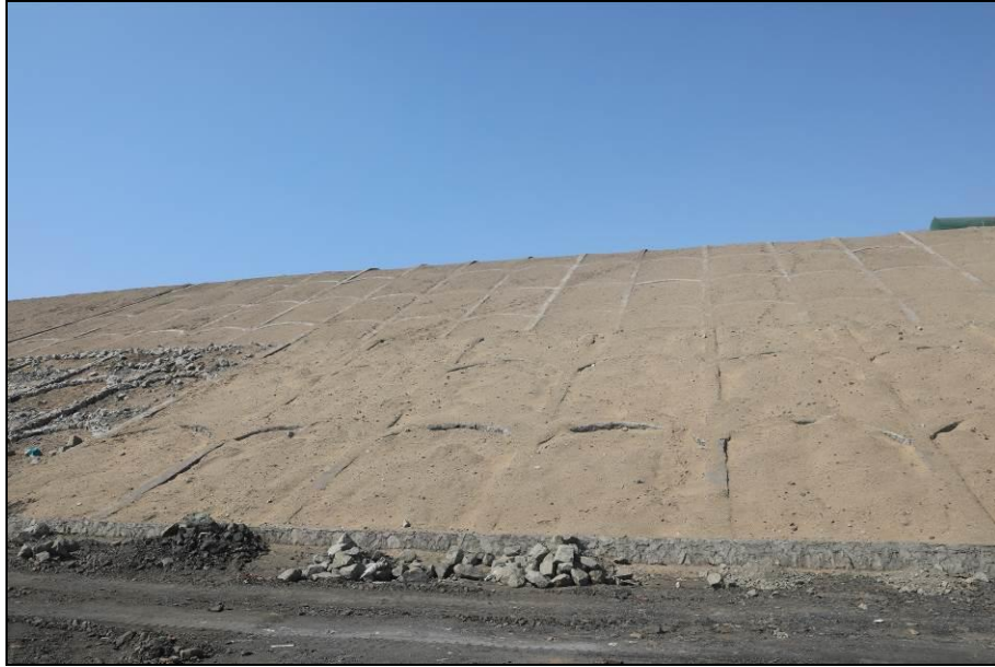
照片4-19 华银三矿外排土场东部边坡治理
