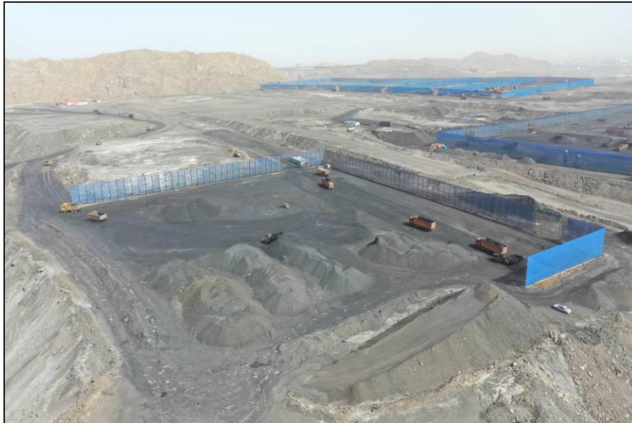
照片 4-1 华银二矿储煤场
