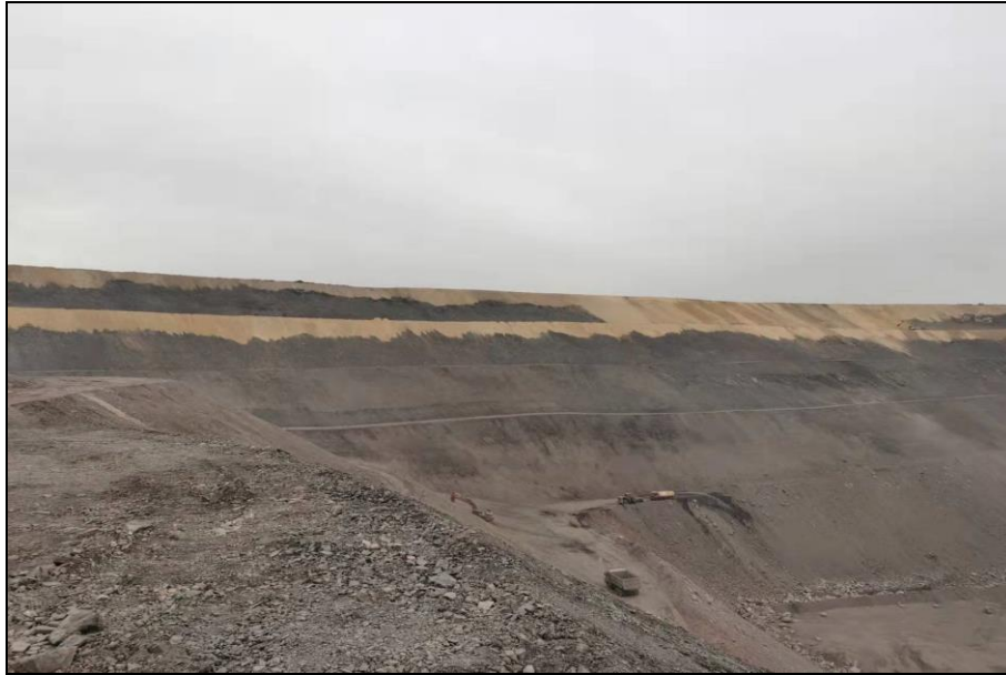
照片4-26 华银采空治理区双人山外排土场WP-4
