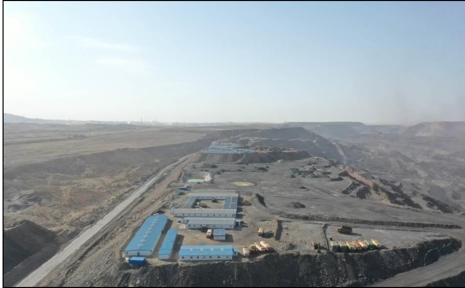
照片 4-4 华银二矿生活区
