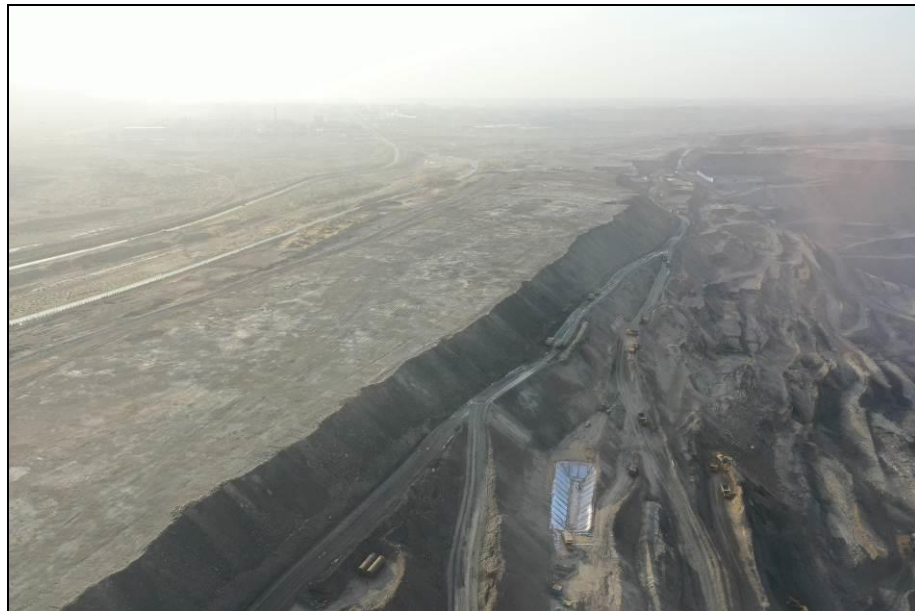
照片4-21 华银二矿西外排土场顶部及东部边坡
