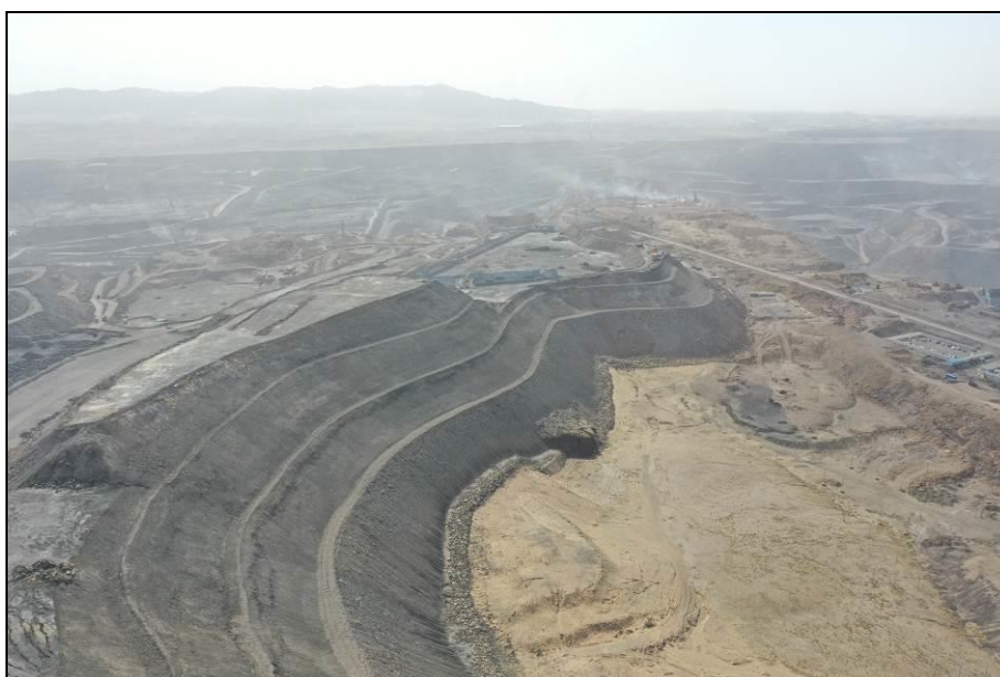
照片4-22 华银二矿东排土场WP-3北部绿地附近边坡
