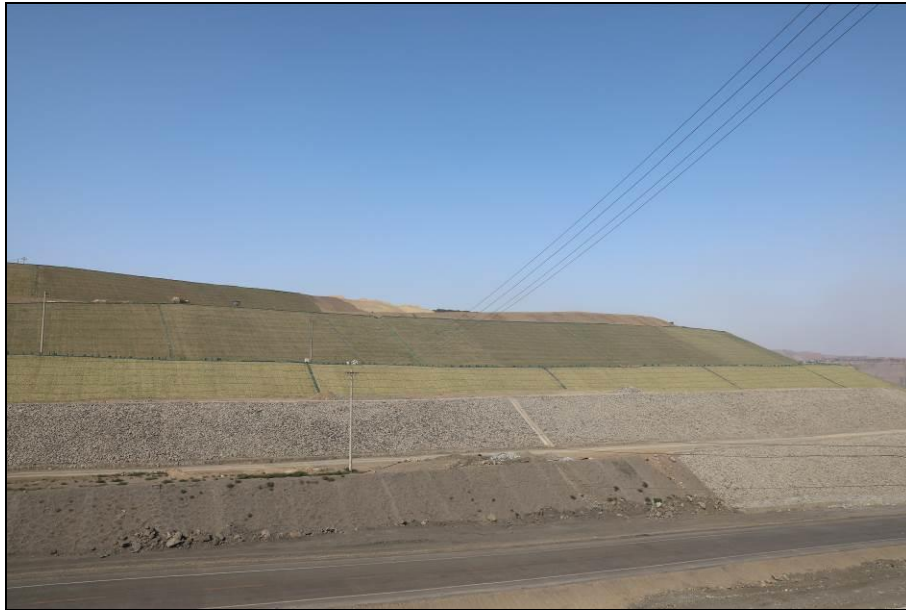
照片4-23 华银二矿东排土场WP-3东部边坡治理
