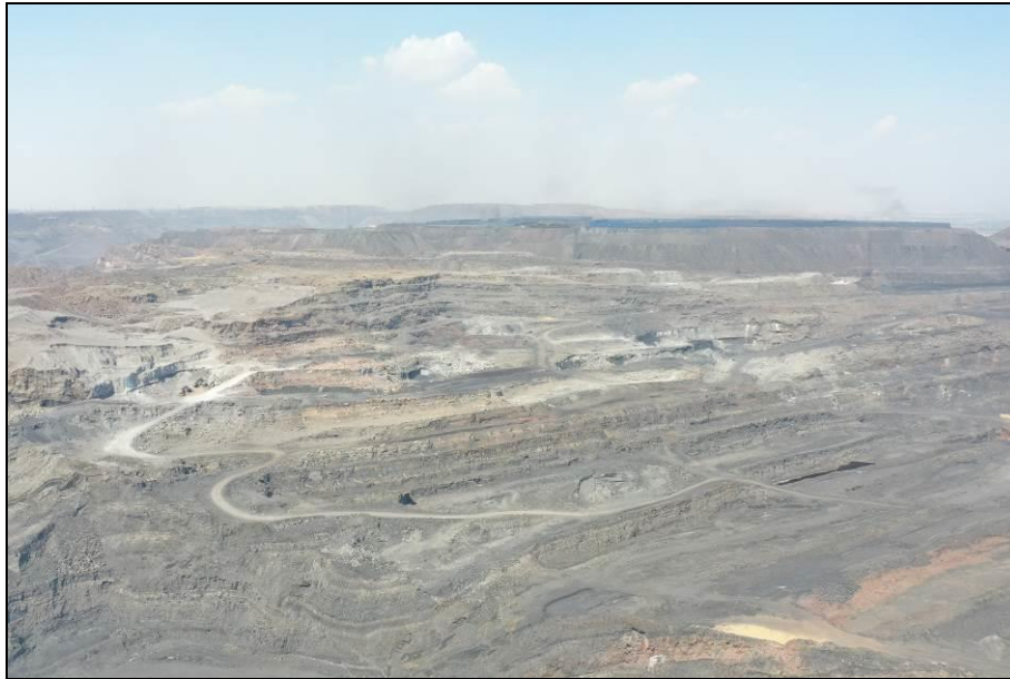
照片 4-17 华银采空治理区剥挖坑 K-3
