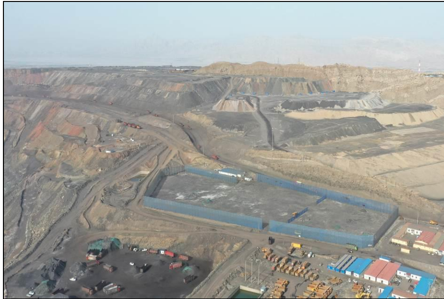
照片 4-2 华银采空治理区储煤场
