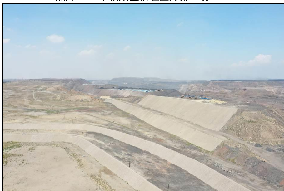
照片4-29 华银采空治理区外排土场WP-5西边坡治理
