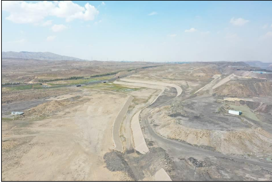
照片 4-10 泄洪渠西段
